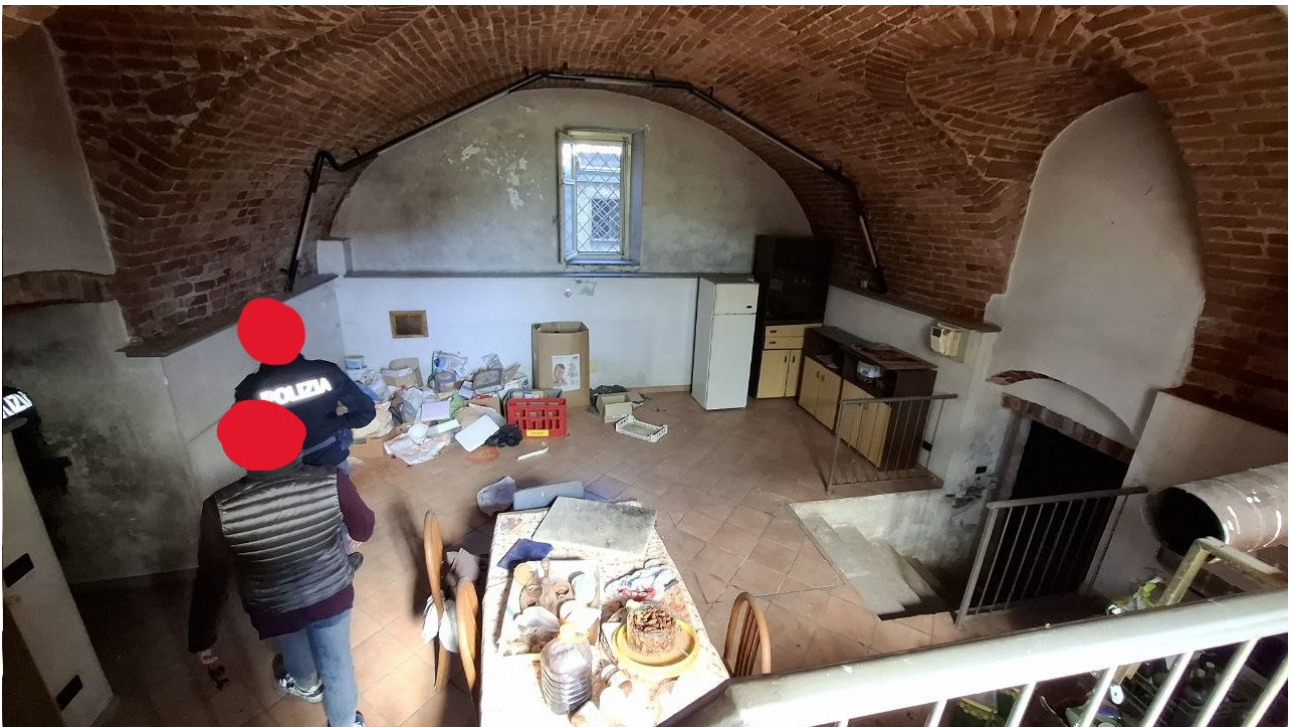
Piano interrato - Cantina
