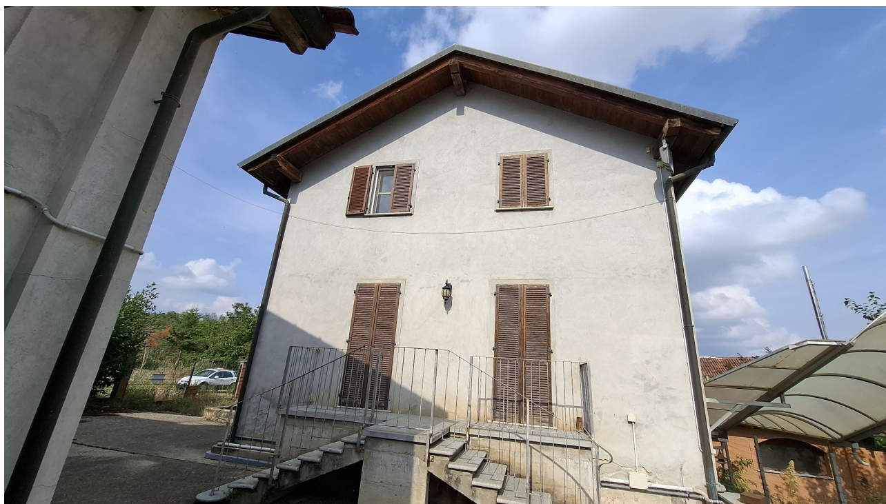
Civile abitazione – esterno (lato sud-ovest)
